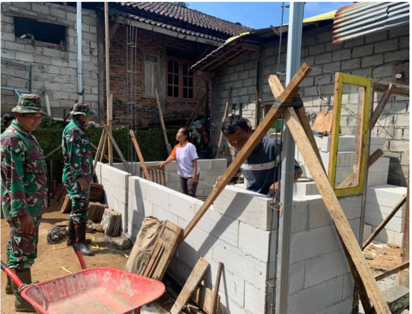
Pemasangan Dinding Menggunakan Herbel
